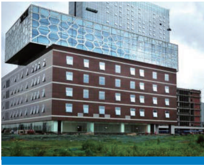
成都地铁控制中心 ▶▶▶
